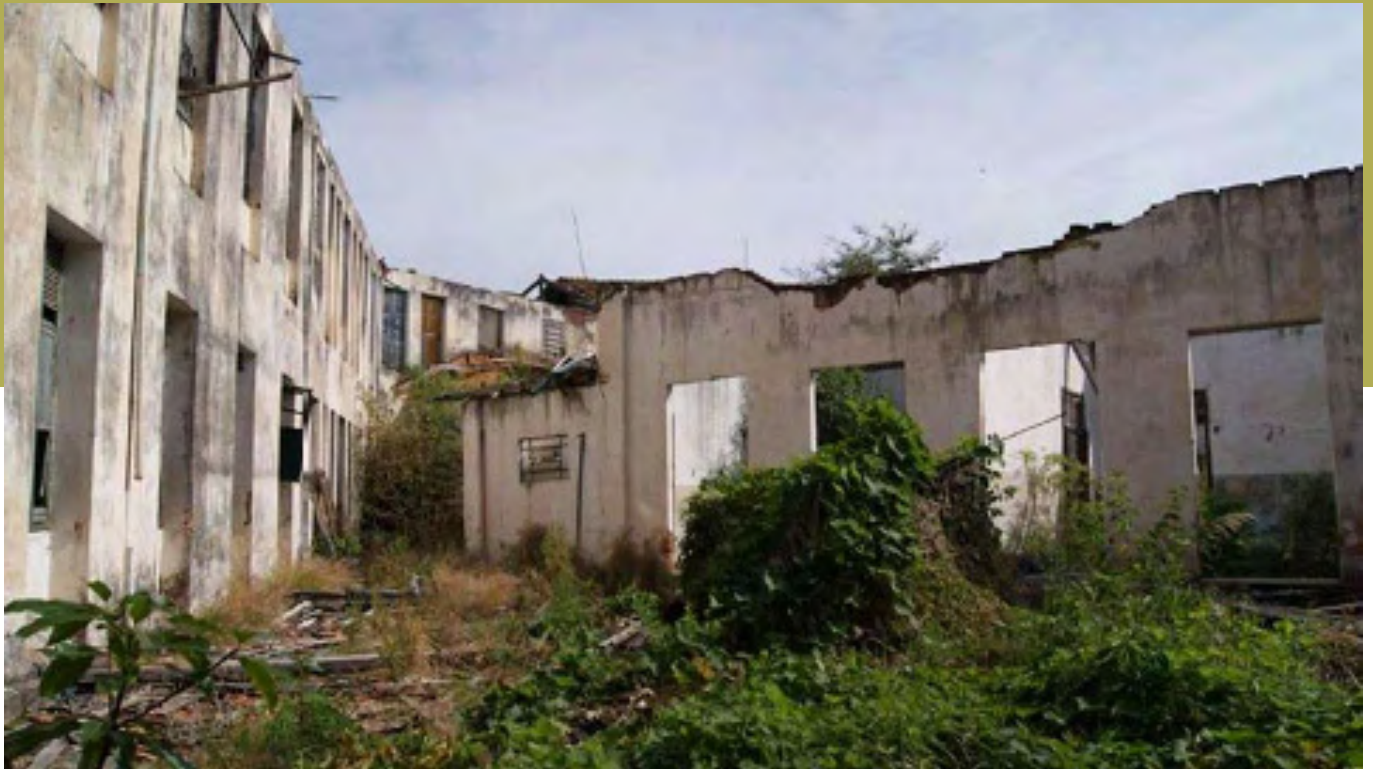
Figura 18: Antigos apoios do hotel totalmente descobertos com vegetação crescendo ao redor. Autor: Rita Cabrelon (2015). Fonte: Inventário Arquitetônico Hotel São Paulo (2016).
