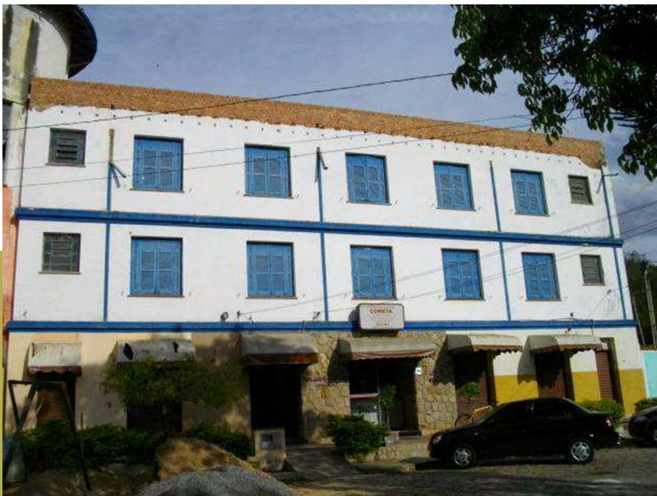
Figura 21: O beiral da ala esquerda foi retirado e transformado em platibanda. Autor: Alice Abreu (2012). Fonte: Inventário Arquitetônico Hotel São Paulo.
