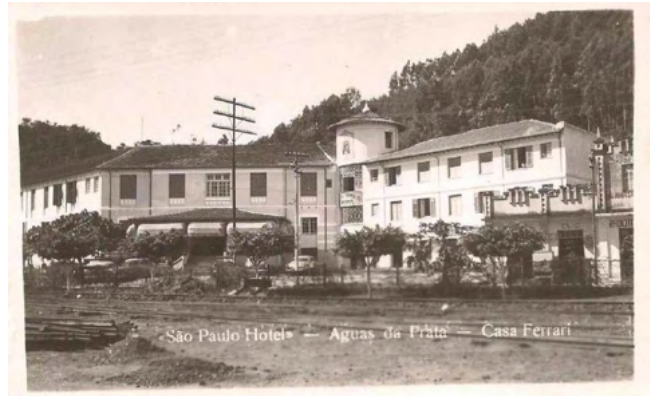
Figura 11: Hotel após reforma de Sinelli realizada na década de 1950. Fonte: acervo Antonio Carlos Rodrigues Lorette apud Inventário Arquitetônico São Paulo Hotel (2016).
