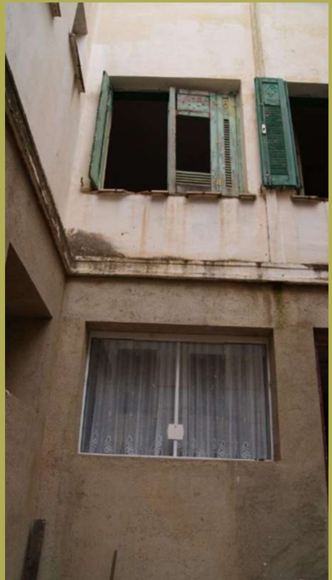
Figura 22: Troca das janelas por vidros temperados. Autor: Priscila Dotta (2015). Fonte: Inventário Arquitetônico Hotel São Paulo.
