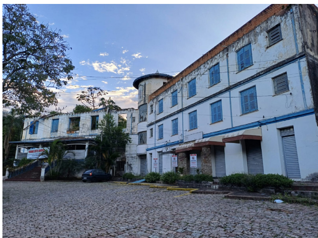
Figura 15: Fachada do hotel. Autor: Ana Cristina Domingos Ferreira (2025).
