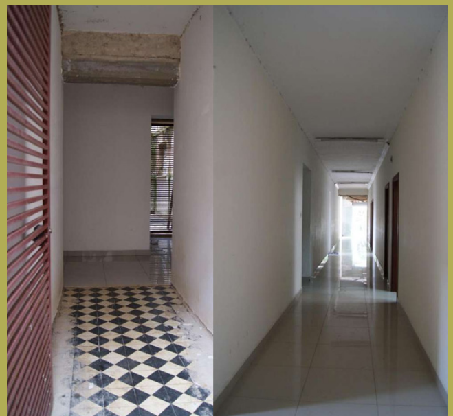
Figura 23: Comparação do piso original e com o da reforma. Autor: Rita Cabrelon (2015). Fonte: Inventário Arquitetônico Hotel São Paulo.
