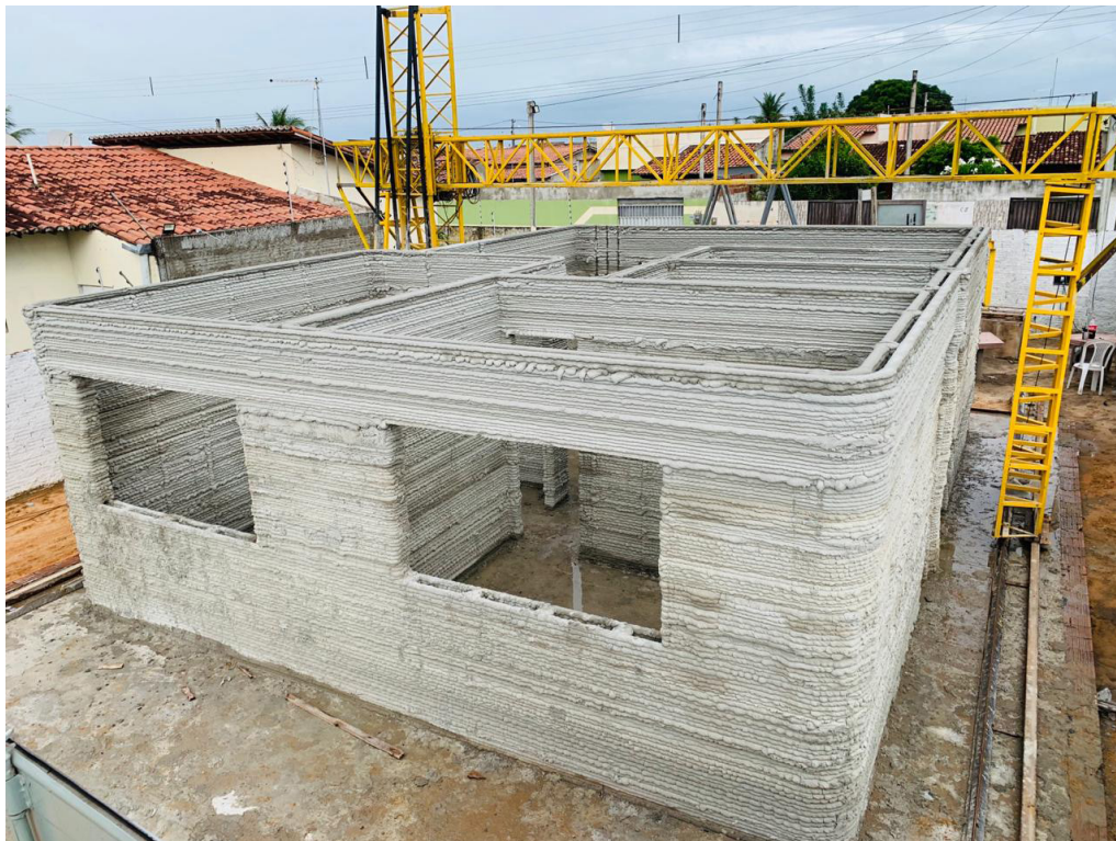
Figura 3: Primeira residência construída a partir de impressão 3D no Brasil. Fonte: Stylo Urbano, site oficial Stylo Urbano. Disponível em: https://www.stylourbano.com.br/3dhomeconstruction-constroi-a-primeira-casa-de-impressao3d-do-brasil/ .
