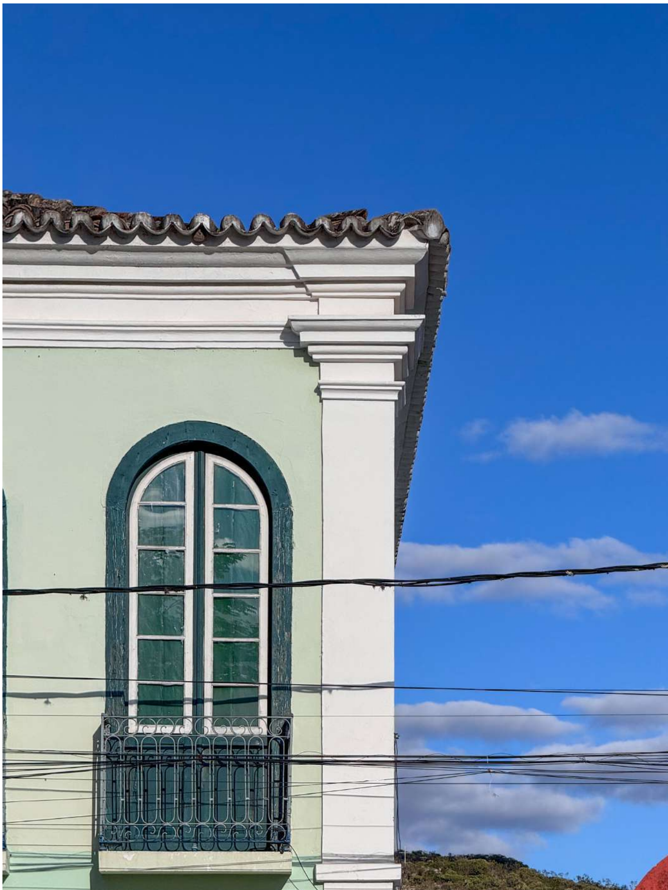
Figura 8: Uma imersão nos elementos arquitetônicos do segundo pavimento de uma casa colonial no centro de Mucugê. (2025).
