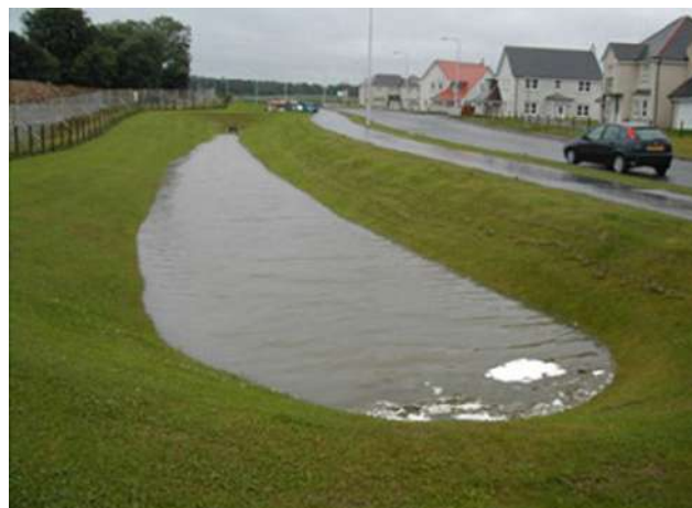
Figura 13: Bacia de retenção. Fonte: SuDS Wales, c2024k, p.1. Disponível em: < https://www.sudswales.com/types/passive-treatment/detention-basins/ >. Acesso em: 23 jan. 2024.
