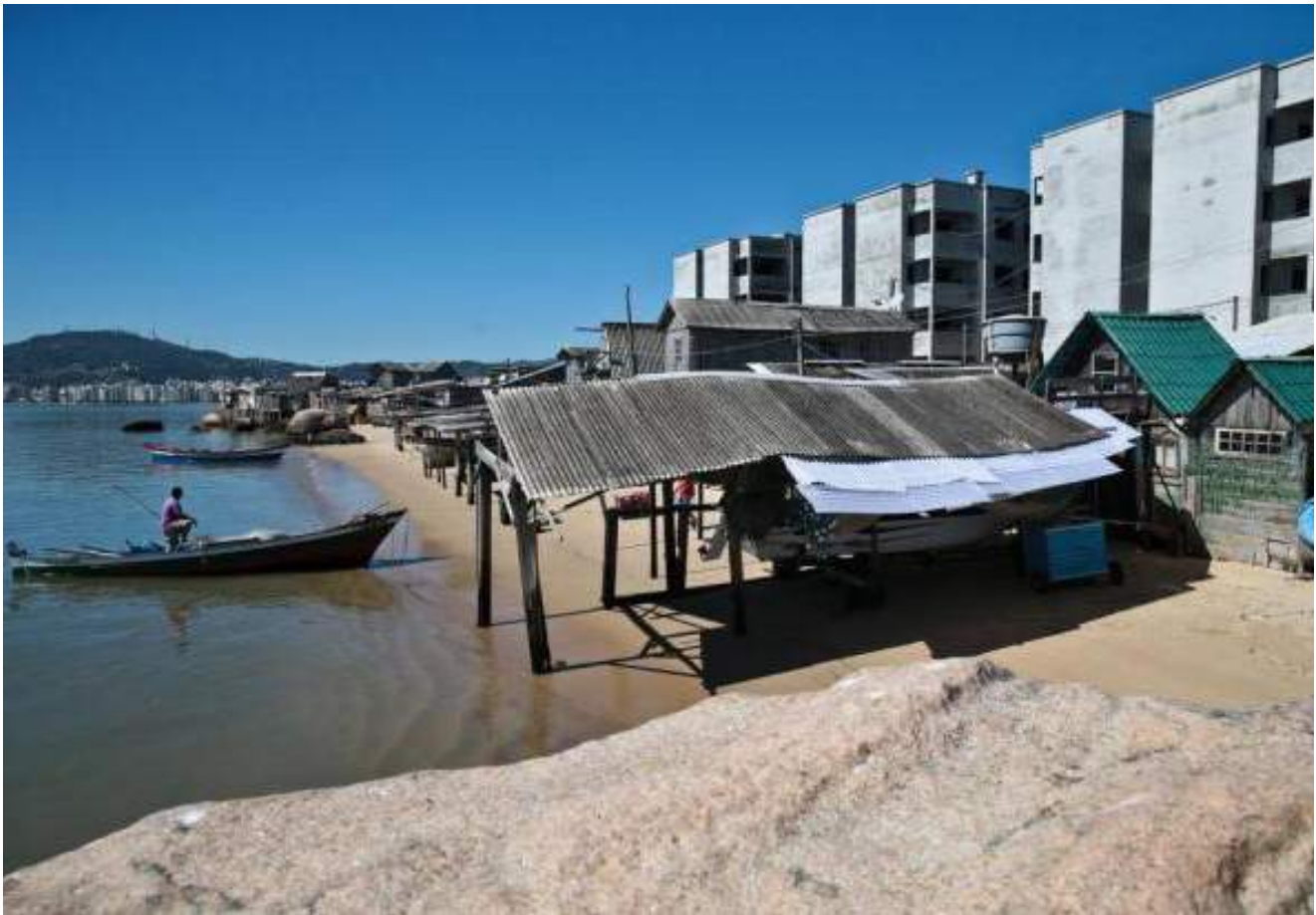
Figura 2 - Habitações atuais sob a água e o novo conjunto habitacional ao fundo. Fonte: Cristiano Estrela/ Agência RBS.
