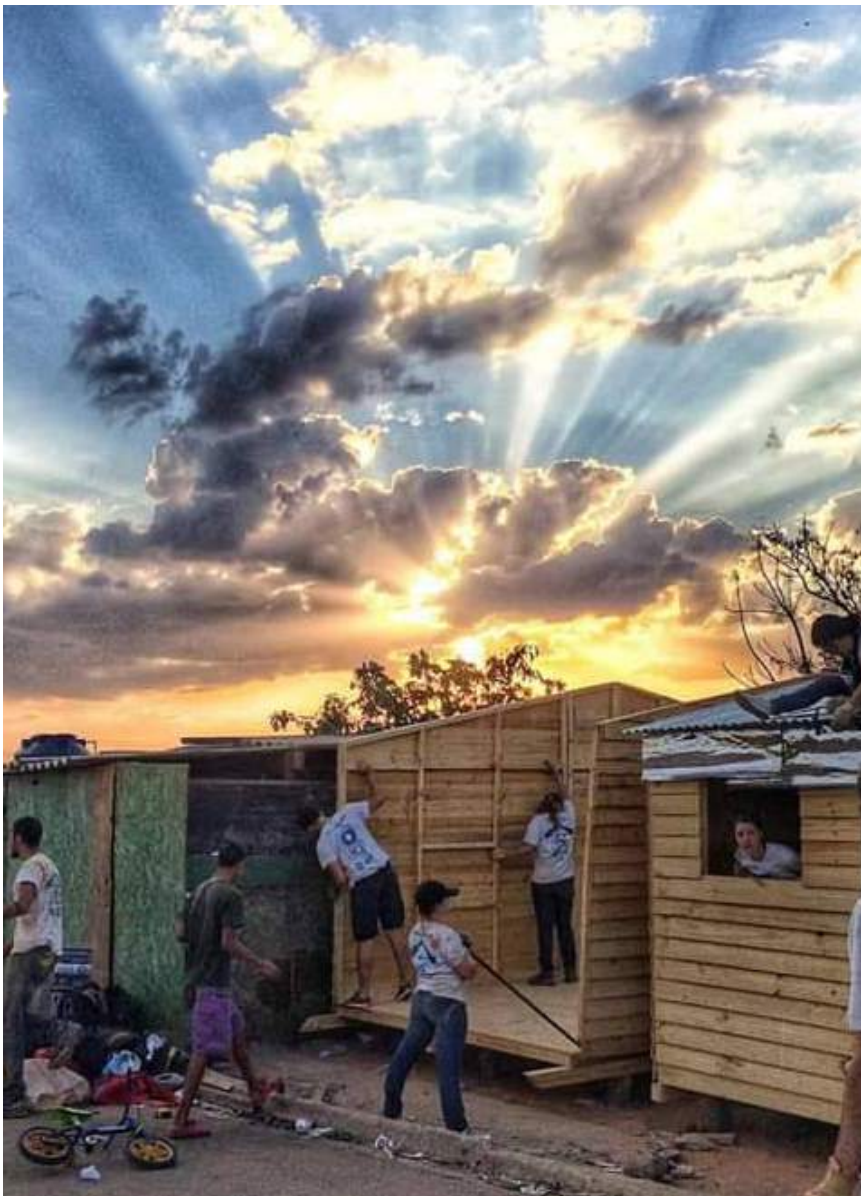
Construção na Itatiaia
