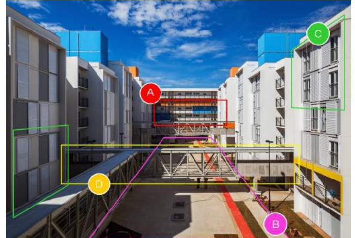
Figura 4: Análise dos elementos arquitetônicos externos do conjunto habitacional Heliópolis - Gleba G. Fonte: Adaptado de: Archdaily, 2011.
