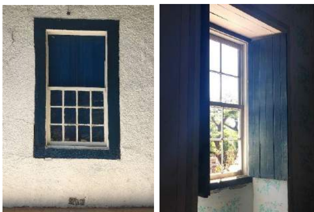
Figuras 2 e 3: Detalhamento das aberturas trabalhadas em madeira e vidro, evidenciando as espessuras das paredes proporcionadas pela técnica construtiva da taipa. Fonte: Acervo da Autora.
