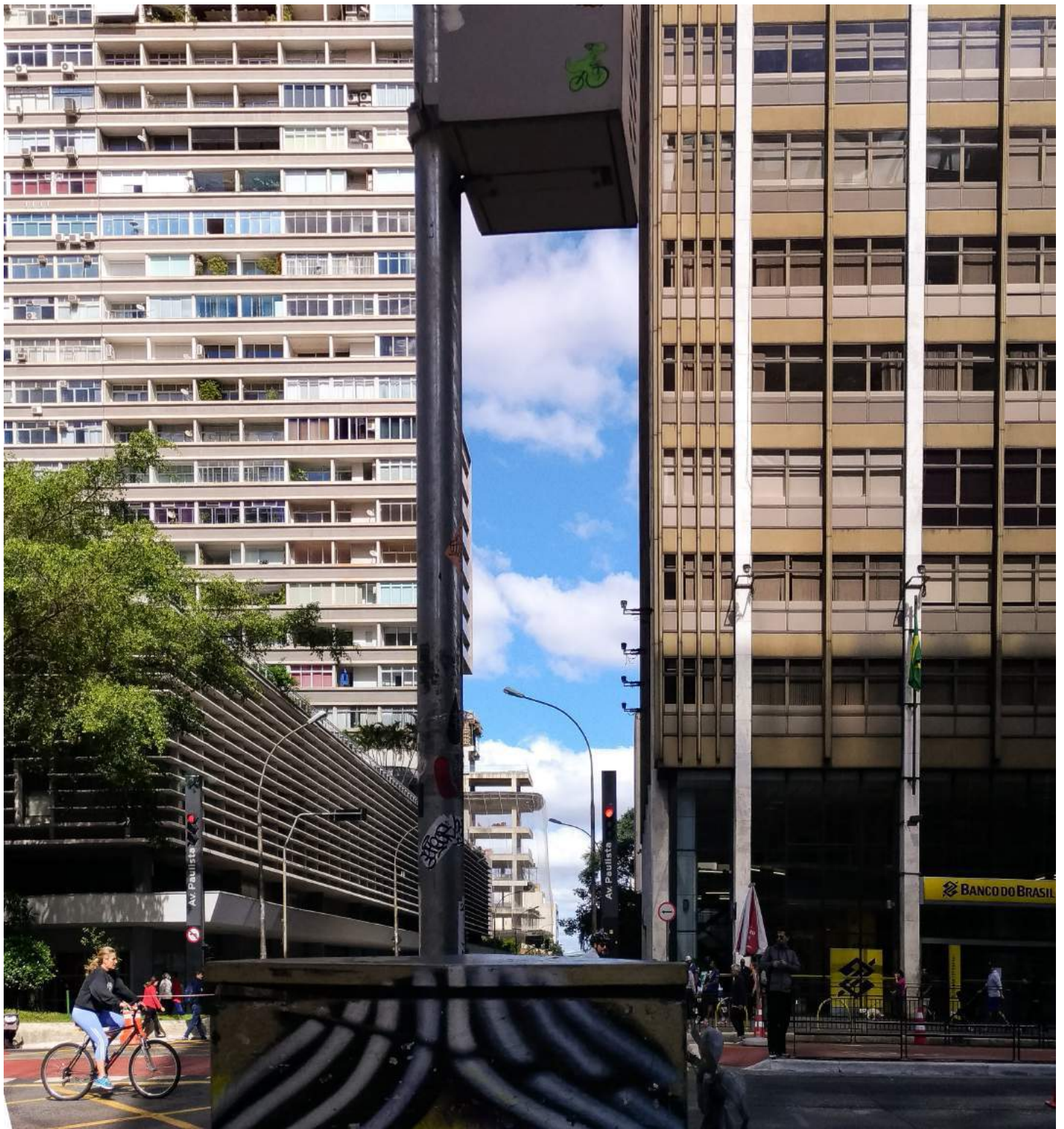
Edifício: Conjunto Nacional e Edifício do Banco do Brasil Foto: Ingrid Sanches
