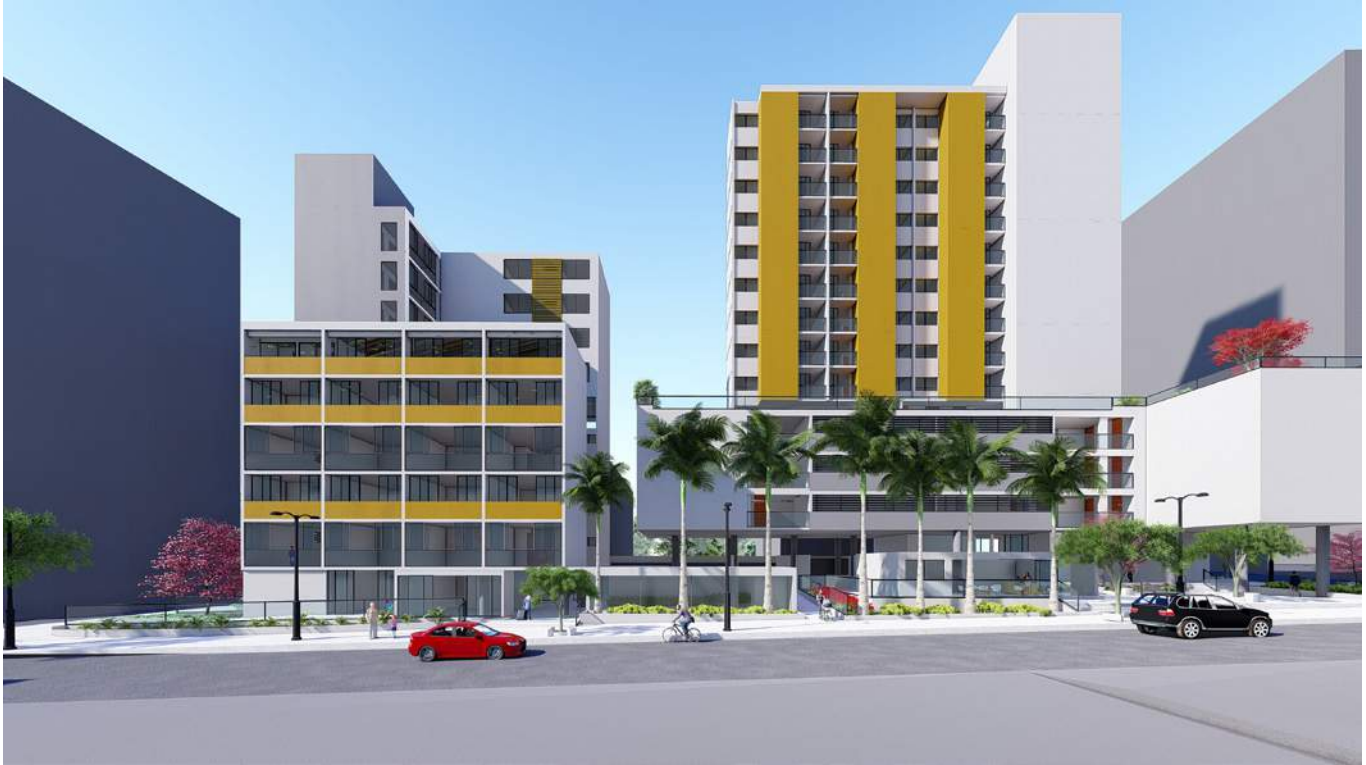
Imagem 3: Vista da quadra 2.
