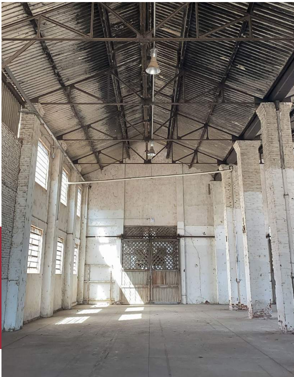
Figura 3 – Foto interna de um dos barracões do Engenho / Fonte: Autoral.
