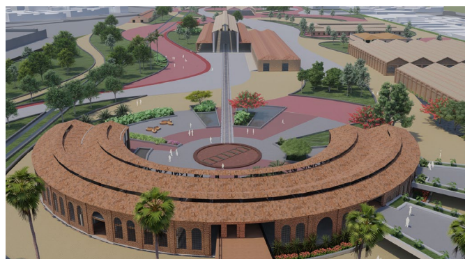
Figura 2- Vista seção oeste do Complexo da FEPASA / Fonte: Autoria do grupo.
