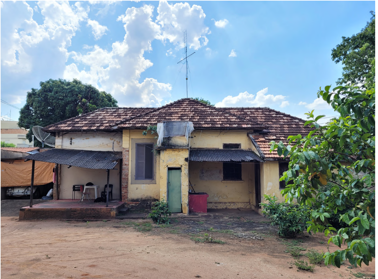
Figura 5 [Fotografia da fachada leste. Autor: Daniel Cardoso (2023).]
