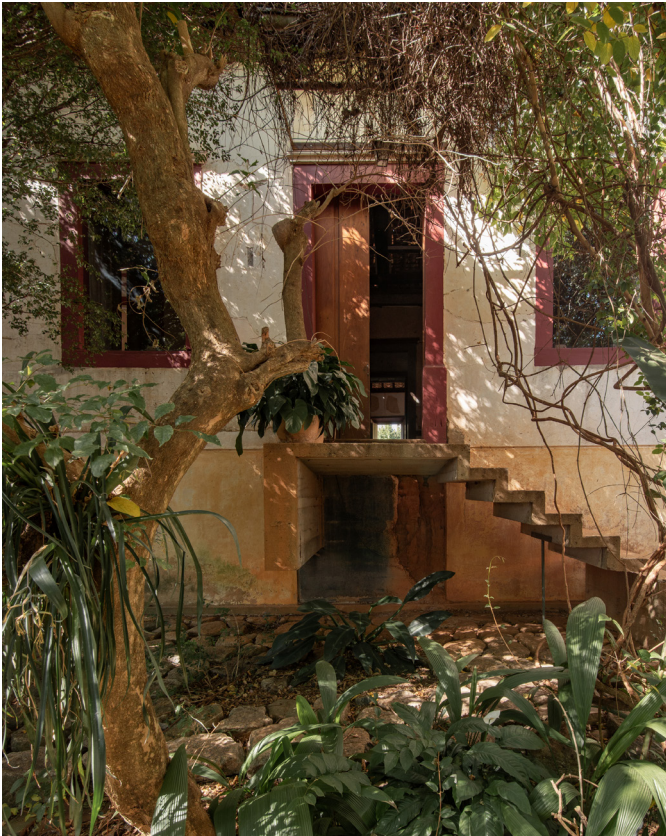
Figura 05 [Nova Escada de Concreto. Autor: Lela Leme (2023).]
