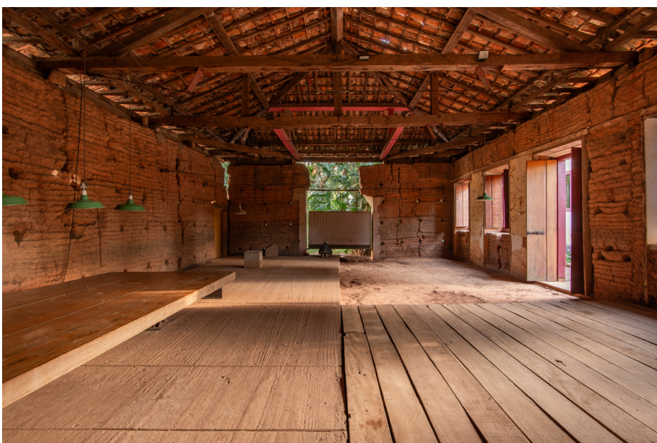
Figura 04 [Tirantes Metálicos em Travamento Triangular, Novos Elementos em Vermelho, Estrutura de Concreto, Instalações aparentes. Autor: Lela Leme (2023).]
