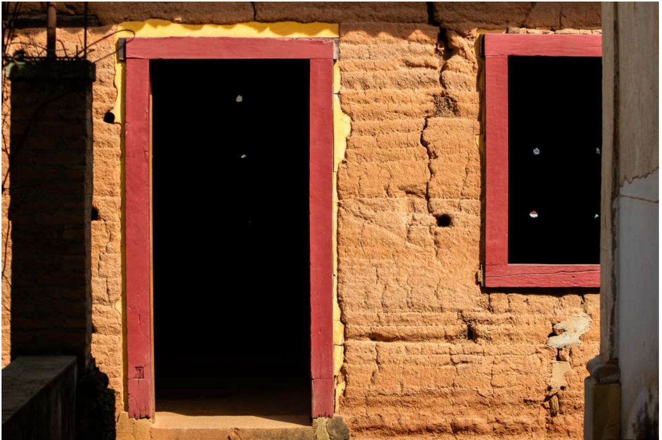
Figura 2 [Casa Grande e Tulha. Autor: Isabela Slywitch (2023).]
