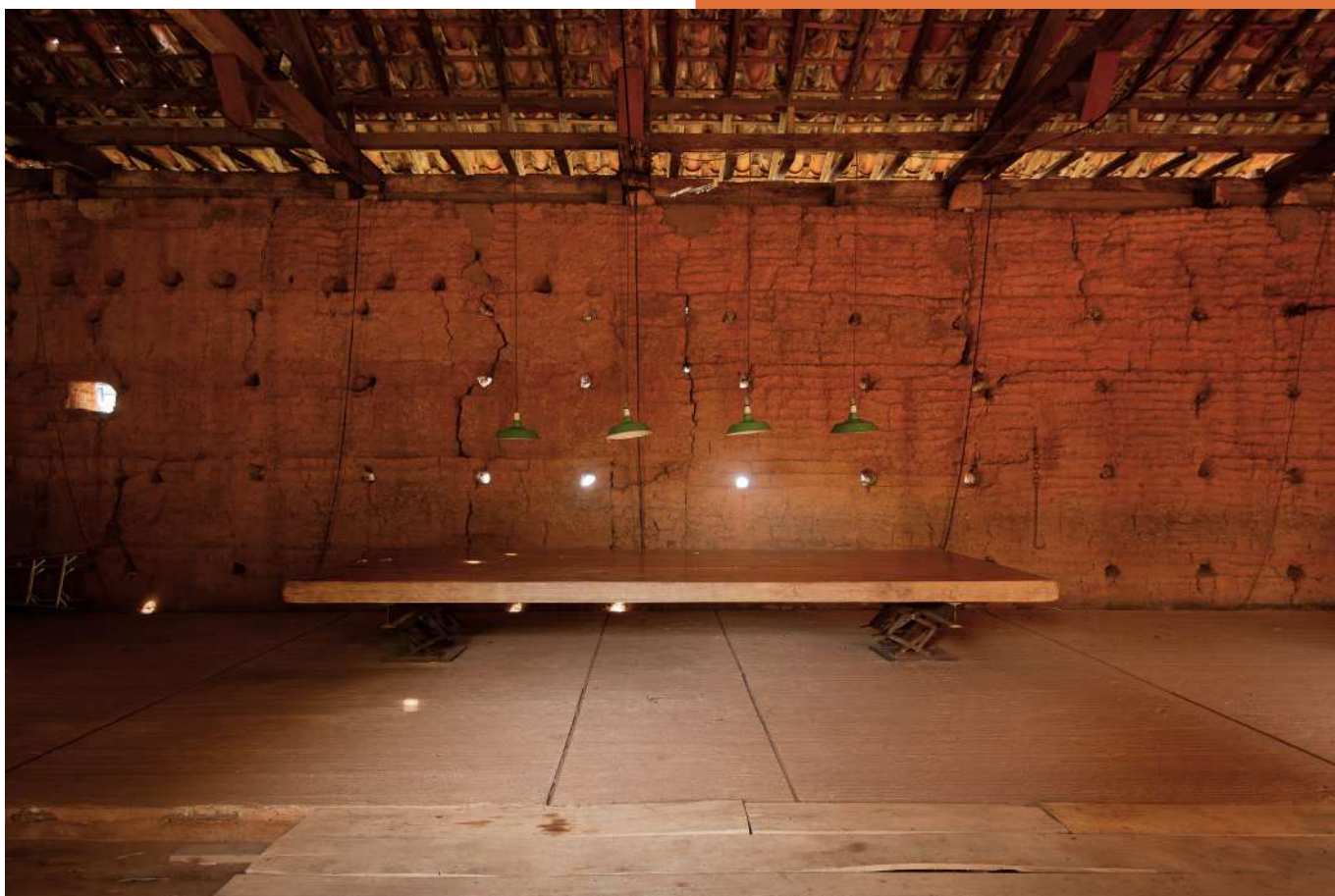
Figura 17 [Casa Grande e Tulha. Autor: Isabela Slywitch (2023).]
