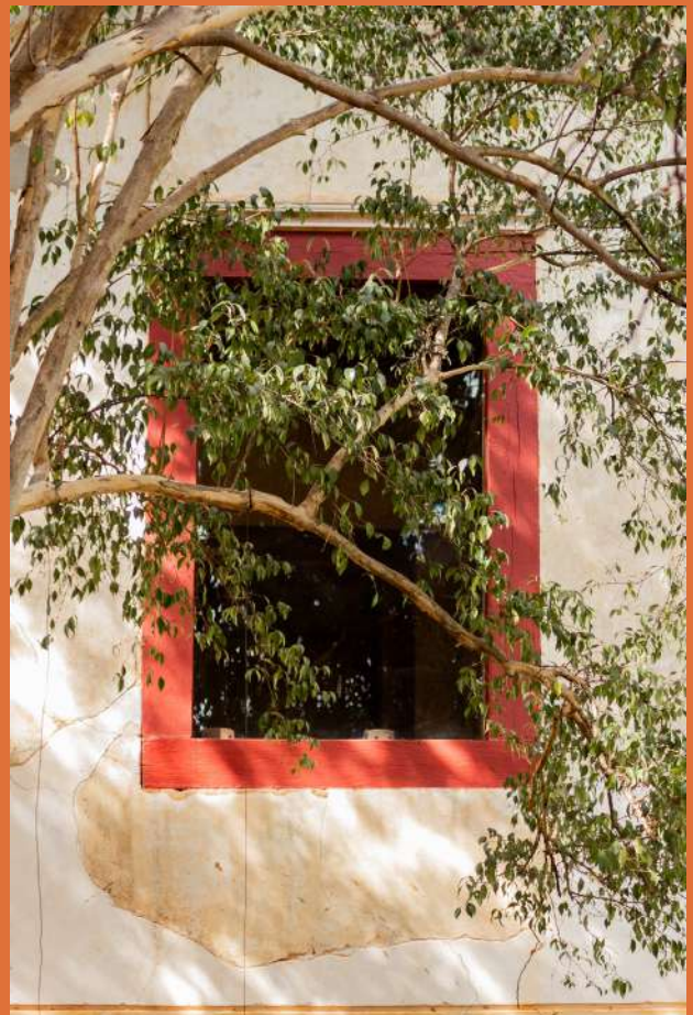
Figura 3 [Casa Grande e Tulha. Autor: Isabela Slywitch (2023).]
