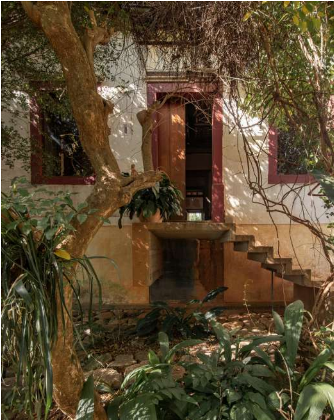
Figura 05 [Nova Escada de Concreto. Autor: Lela Leme (2023).]
