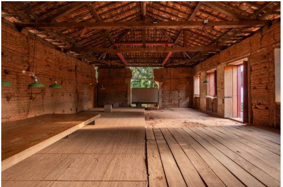
Figura 04 [Tirantes Metálicos em Travamento Triangular, Novos Elementos em Vermelho, Estrutura de Concreto, Instalações aparentes. Autor: Lela Leme (2023).]
