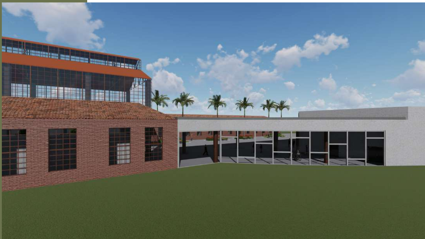
Figura 15: Encontro entre o edifício novo e o antigo. Autor: imagem produzida pela equipe.
