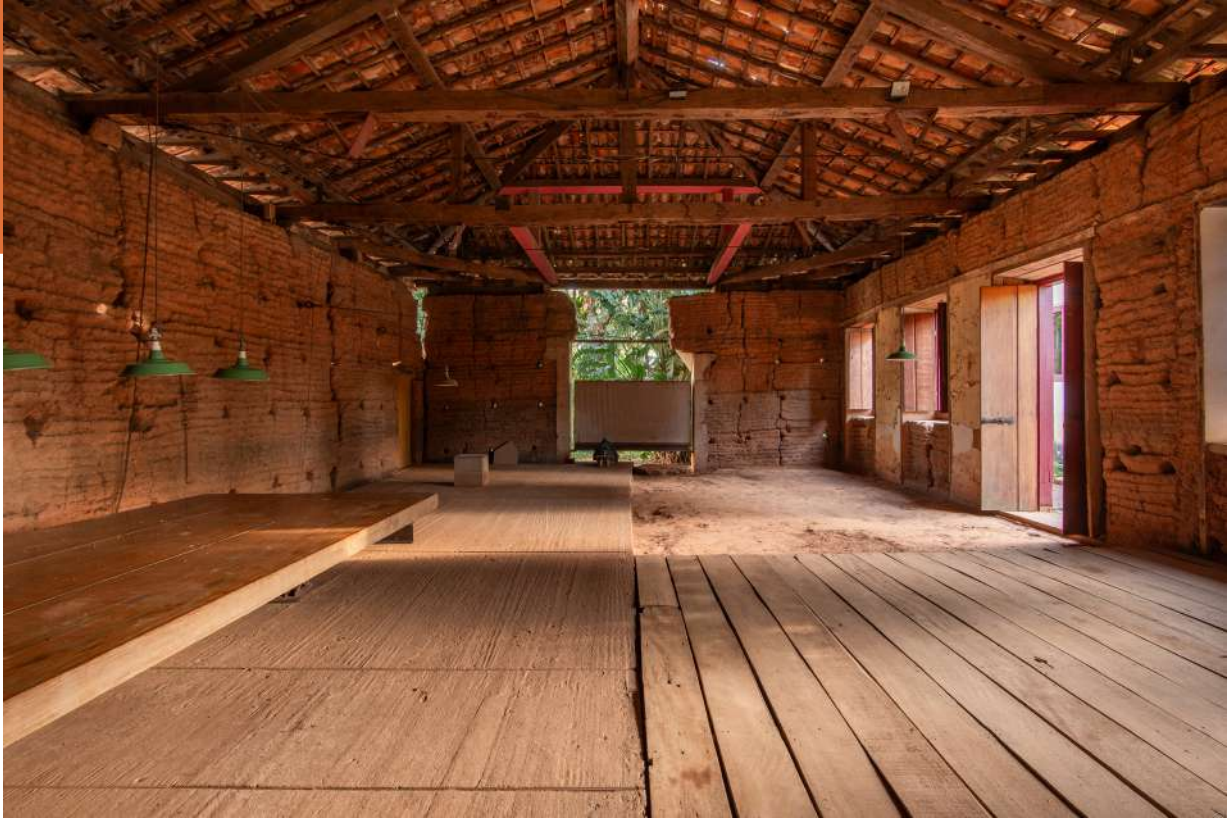
Figura 13 [Casa Grande e Tulha. Autor: Lela Leme (2023).]
