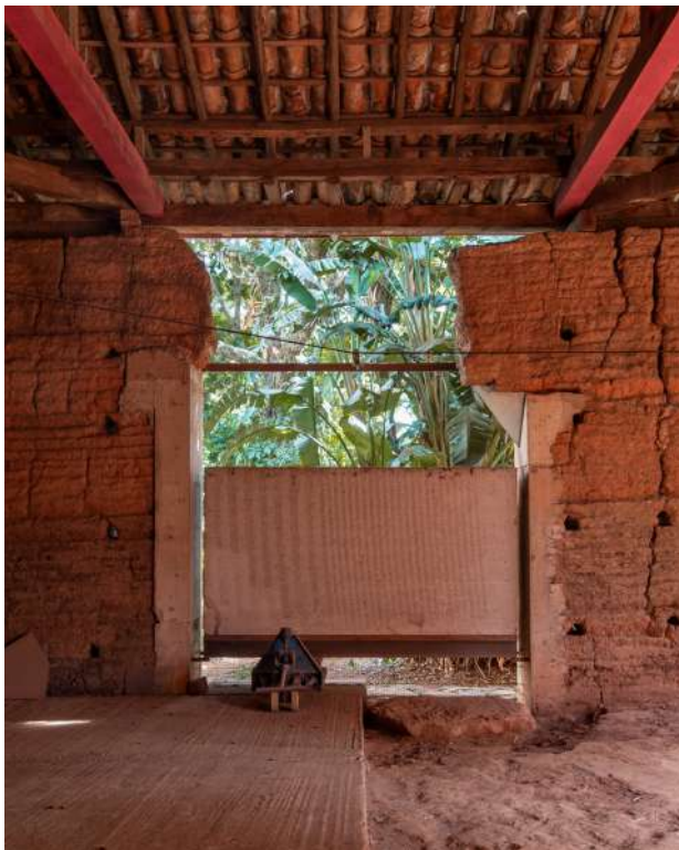
Figura 14 [Casa Grande e Tulha. Autor: Lela Leme (2023).]
