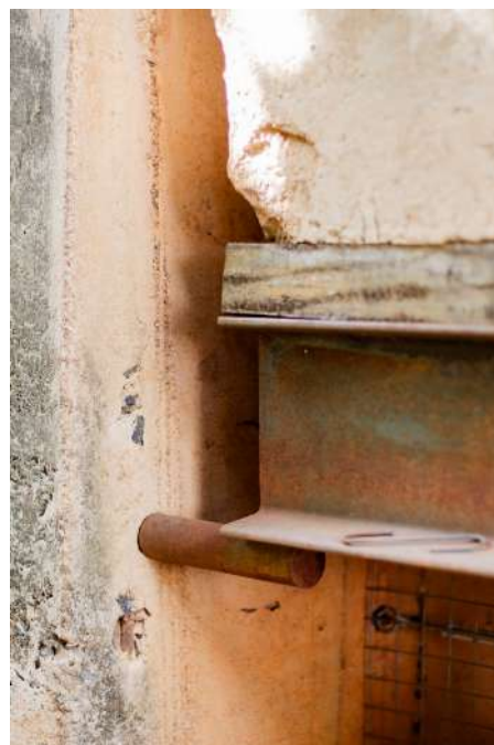
Fotografia 2 [Detalhe Estrutural do portão na intervenção arquitetônica de Antônio Costa Santos na Tulha. Isabela Guimarães Slywitch, 2023]
