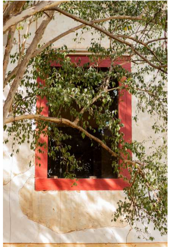
Figura 06 [Recuperação do Revestimento. Autor: Isabela Slywitch (2023).]
