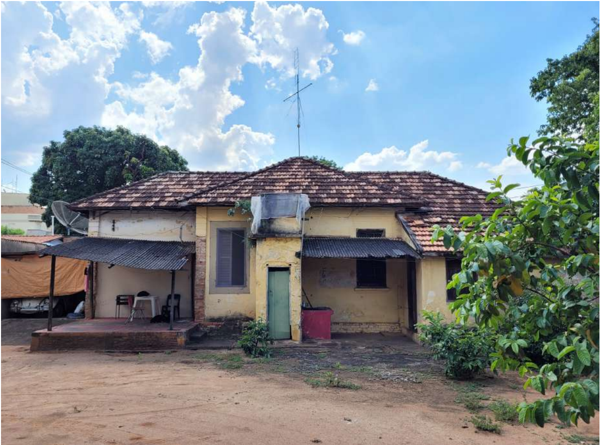
Figura 5 [Fotografia da fachada leste. Autor: Daniel Cardoso (2023).]
