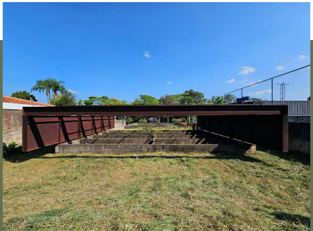
FIGURA 1: Vista do fundo do lote. Fonte: Bia Carvalho Costa Santos, 2023.
