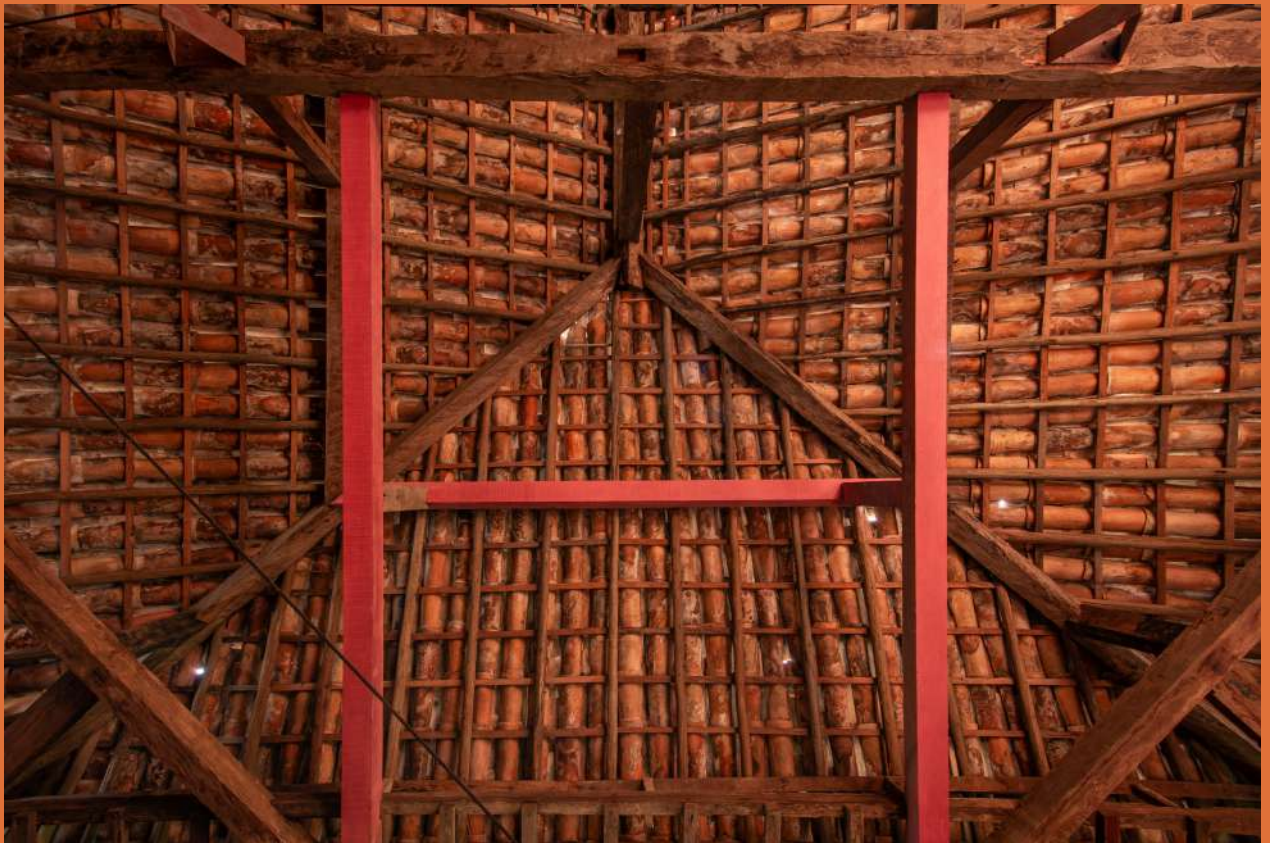
Figura 10 [Casa Grande e Tulha. Autor: Lela Leme (2023).]
