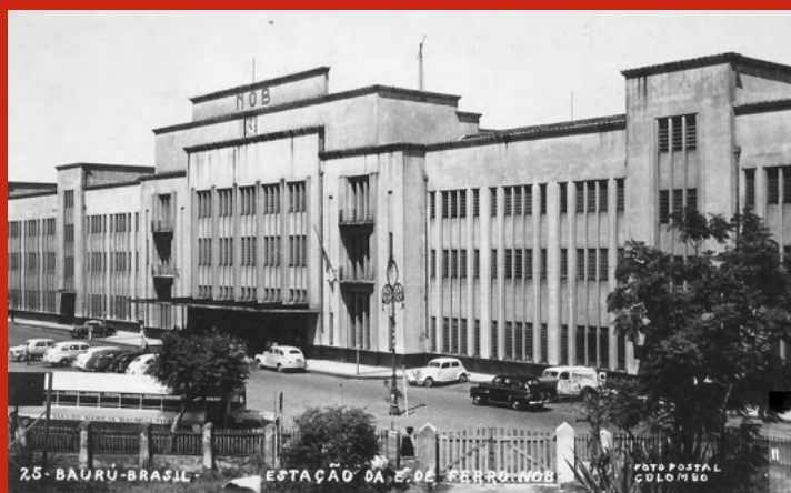
Figura 9: [Estação Central Noroeste em 1950. Fonte: Estações Ferroviárias (c2021).]
