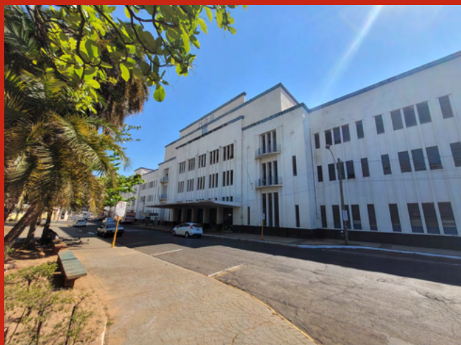
Figura 10: [Estação Central Noroeste atualmente. Fonte: Elaborado pelo autor (2021).]
