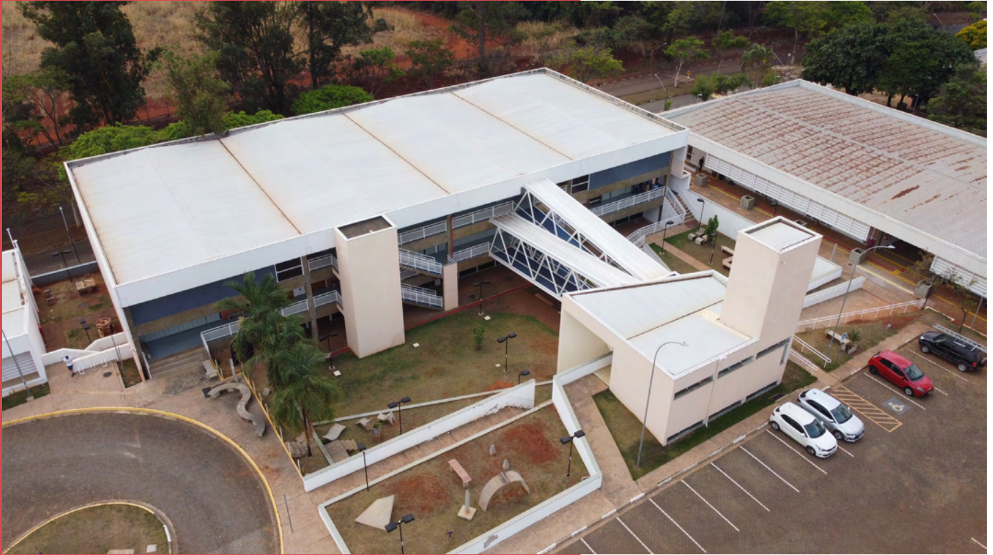
Figura 07: Foto de edificação do Campus I da PUC-Campinas escaneado por fotogrametria utilizando um drone. Fonte: Autoral.
