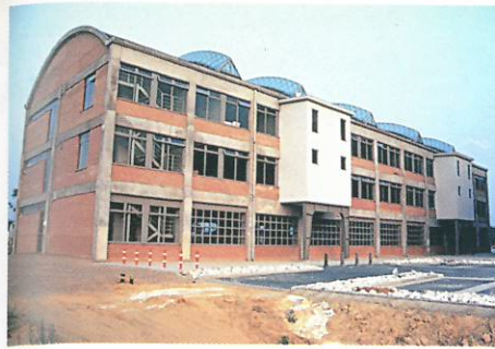
Reciclagem do antigo galpão industrial Wiebenga Hall
