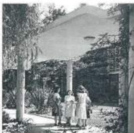
Edifício Sapientiae, em Rino Levi. Acima, foto da época da inauguração. Acervo Digital Rino Levi, FAU PUC-Campinas. Abaixo, situação atual. Fotos Renato Sobral Anelli
