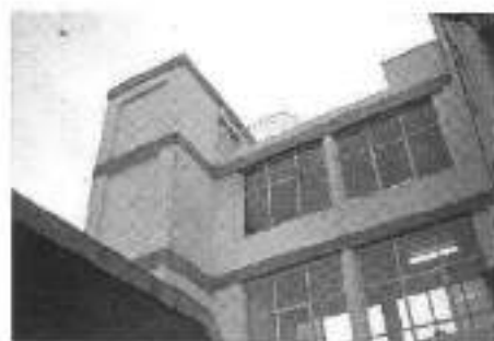
Hospital Churriguera, Buenos Aires. A. Ubaldo Vilar. Foto: F. Costantini
