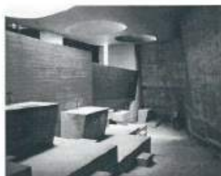
Convento de la Tourette, Arq. Le Corbusier. Foto A. Guerra
