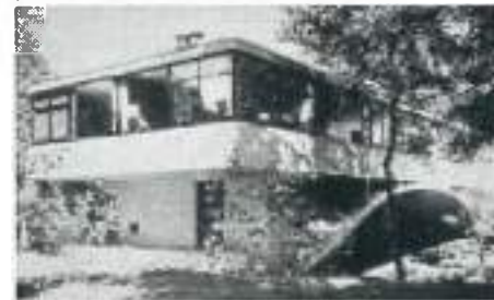
Casa-ponte do arq. Amancio Williams, modernista argentino.
