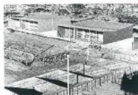
Construção de casas em Brasília pela Novaterra, década de 90
