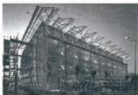
Pavilhão Britânico na Expo-92. Arq. Nicholas Grimshaw
