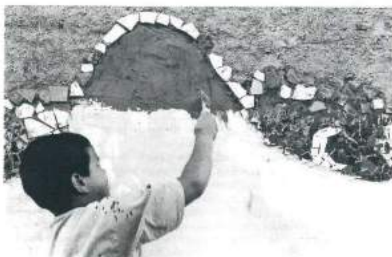
Momento marcante da obra da Vila Brandina, bairro novo da cidade de Campinas. Abaixo, alunos de arquitetura de escolas distantes constroem uma praça para os amigos do bairro. Foto: Rafaela Almeida (M. Itapira)
