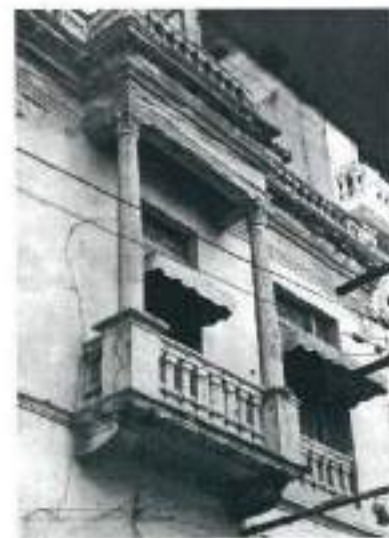
Fachada de edifício na região do "El Tivoli", Santiago de Cuba
