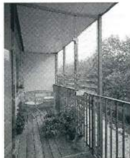
Reapropriação de edifícios do tipo WBS 70 em Dresden. Construção de novos blocos, 1974/1986, arquitetos Krieger und Partner
