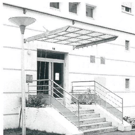
Remodelagem em Lorient, arq Roland Castro. Fotos Nicolas Borel
