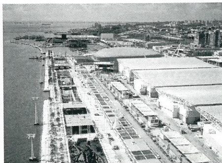
Jardins e equipamentos à margem do rio. Foto Expo 98
