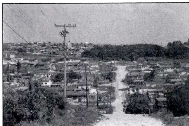
Foto 3. Loteamento Irregular com Infra-Estrutura Precária.
