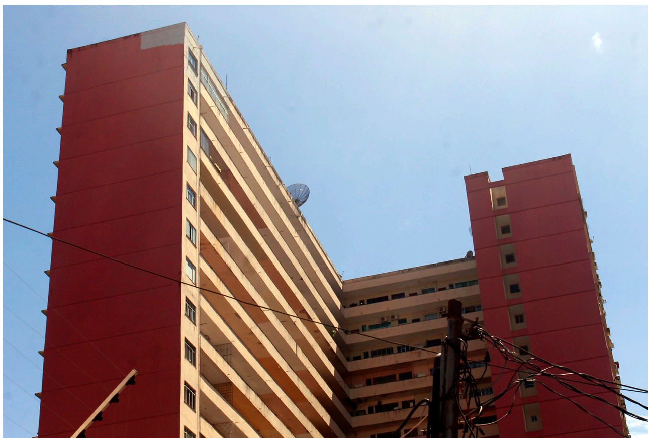
FIGURA 7 — Vista posterior do Ed. Banna (Eng. Arq. Alcyr Meira, década de 1960): detalhe dos corredores de apartamento abertos.
