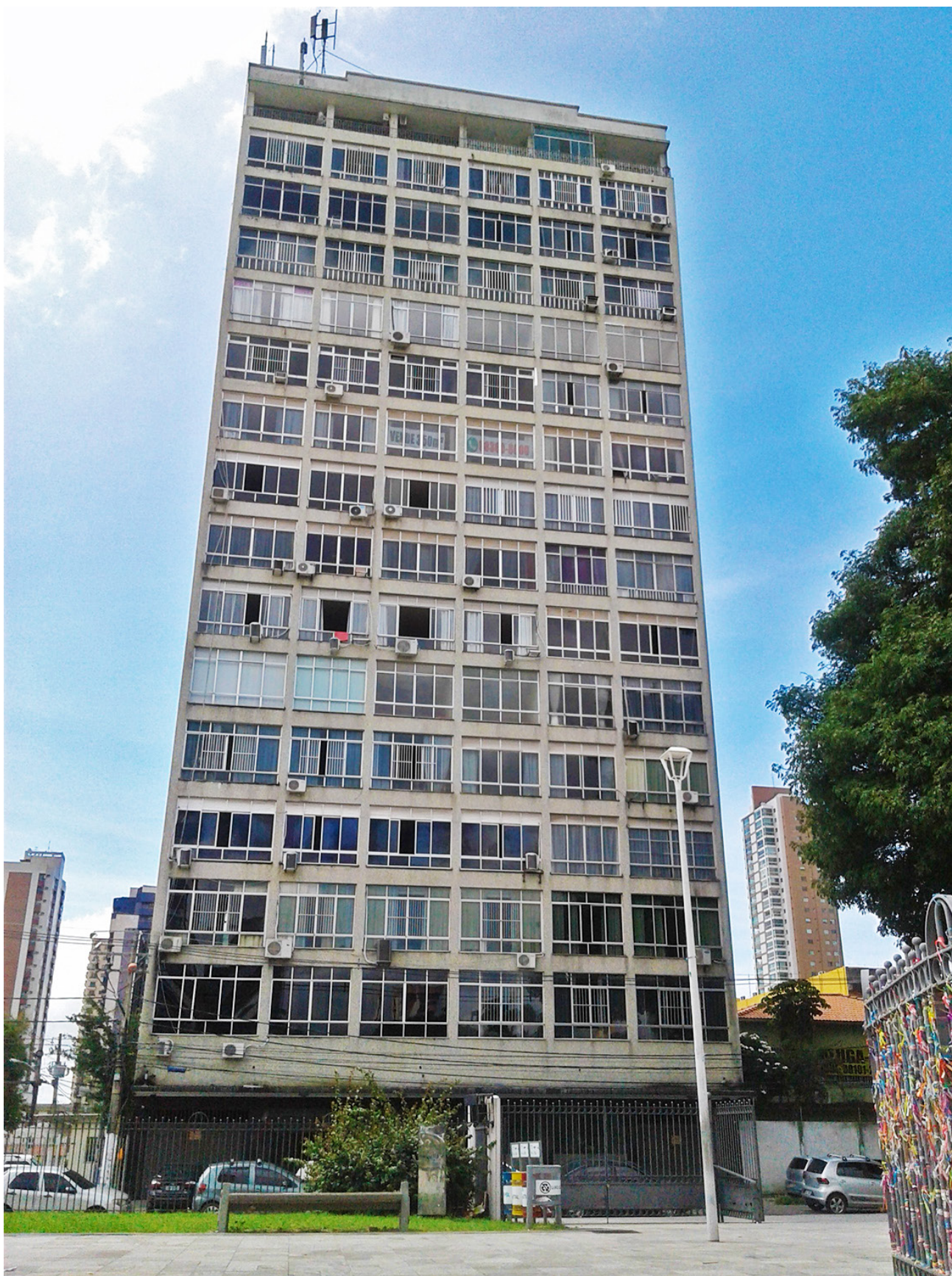
FIGURA 5 — Edifício Rainha Esther, autoria do Eng. Judah Levy (1964).
