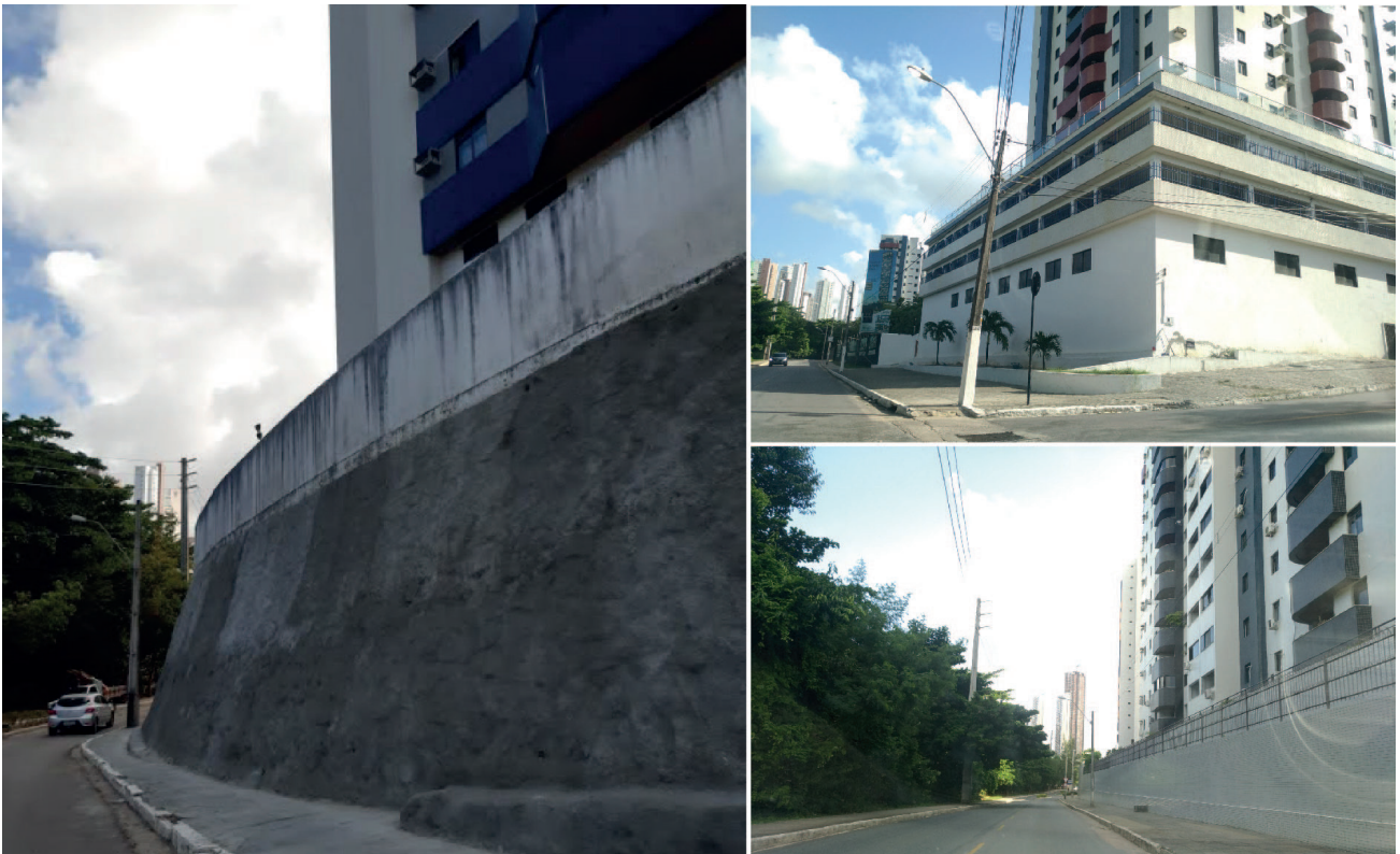
FIGURA 9 — Edificações na Rua Giuseppe de Queiroz - Bairro Miramar.
