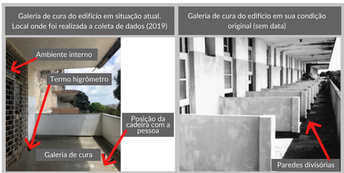
**FIGURA 4** – Demonstração da galeria do segundo pavimento no momento precedente à coleta dos dados e Galeria de cura do quarto pavimento do Hospital Sanatório Santa Terezinha em sua condição original (sem data) que mostra as paredes divisórias como solução adotada em todos os pavimentos.
