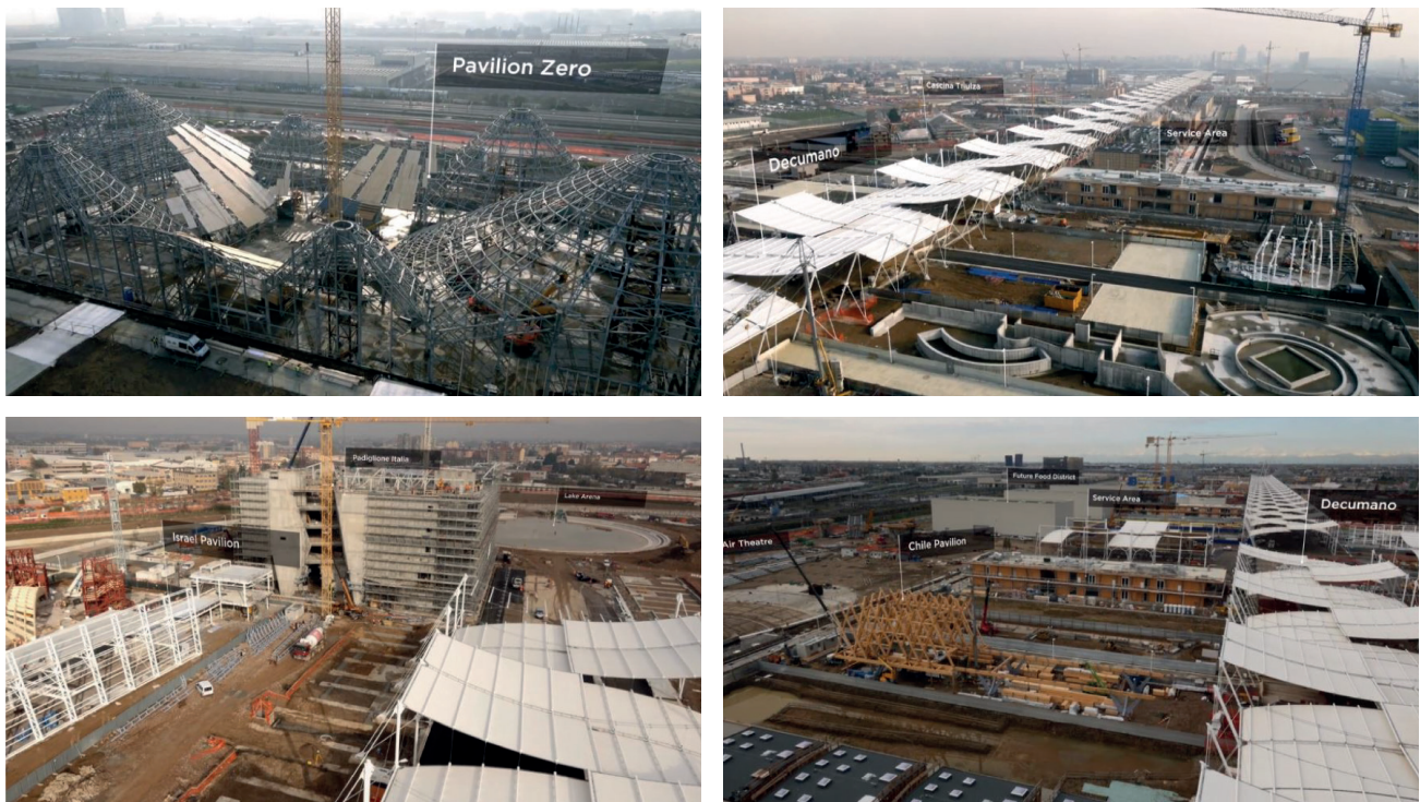
FIGURA 3 — Imágenes del proceso de edificación Expo Milan 2015, generadas por VANT.
