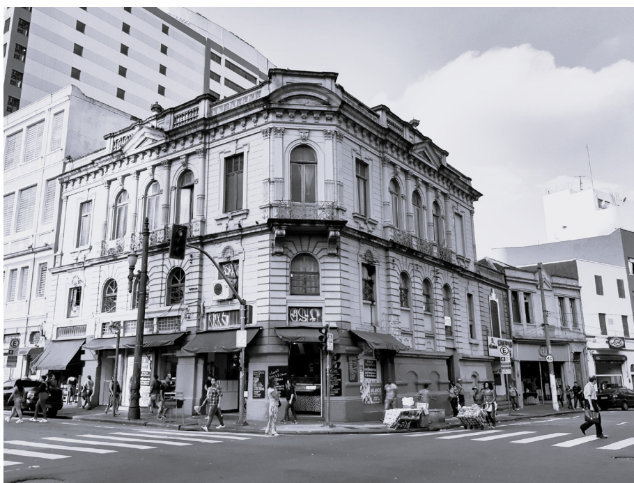
Figura 1 – Edifício localizado na esquina da rua Florêncio de Abreu com rua Paula Souza.
