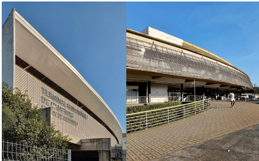
Figura 3 – Fotomontagem com as fachadas do Terminal intermodal de passageiros (2004-08), Badaró e Ferreira, Campinas. Fonte: Acervo dos autores (2024).
