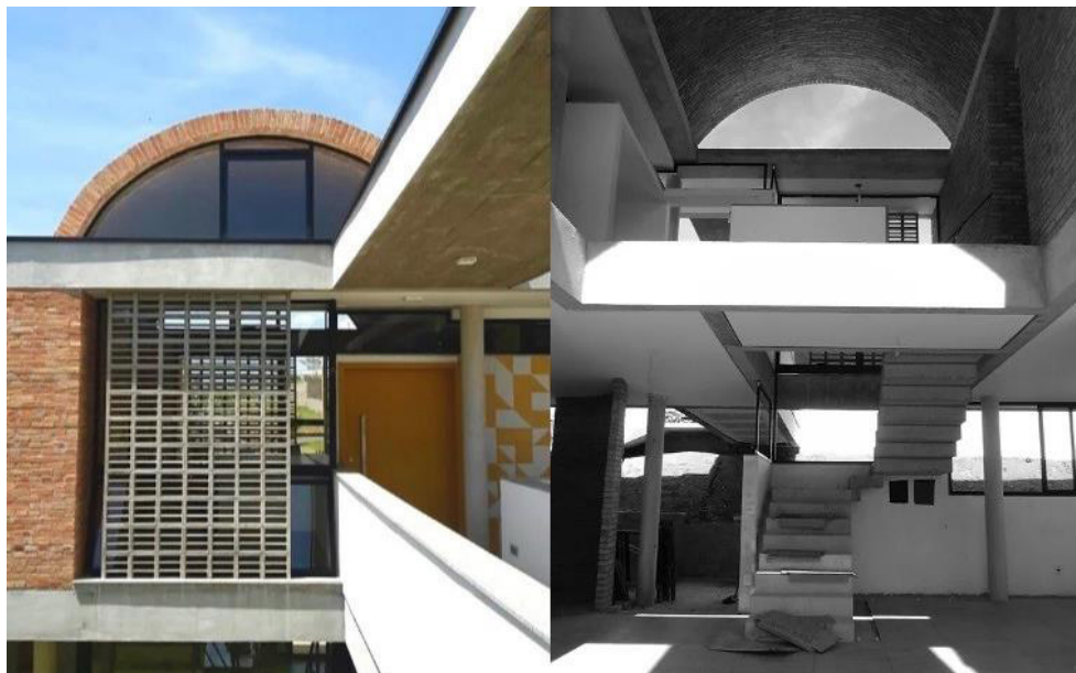
Figura 8 – Fotomontagem com fachada e interior da Casa em Campinas (2014), Araújo + Pereira Pinto.
