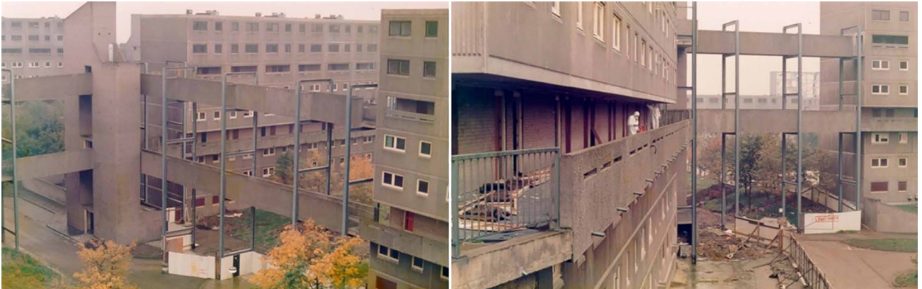
Figura 6 - Acessos verticais e ‘ruas elevadas’ sem controle de acesso - Conjunto Killingworth, Killingworth, Inglaterra.
