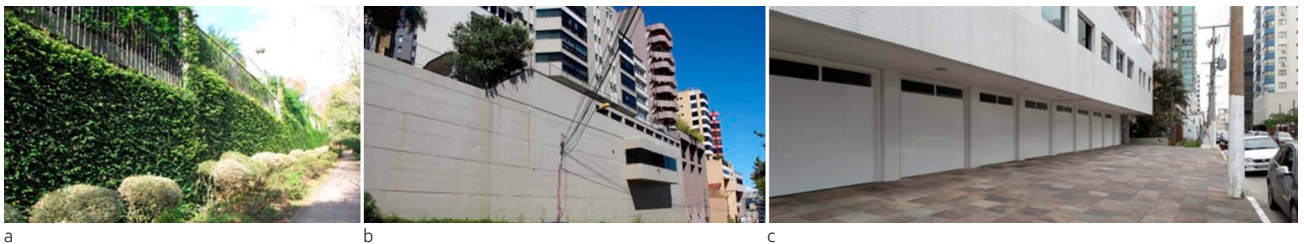
Figura 5 – Edificações delimitadas por muro, parede cega e portas de garagem.
